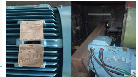
APL 燃氣風扇200HP馬達更換
